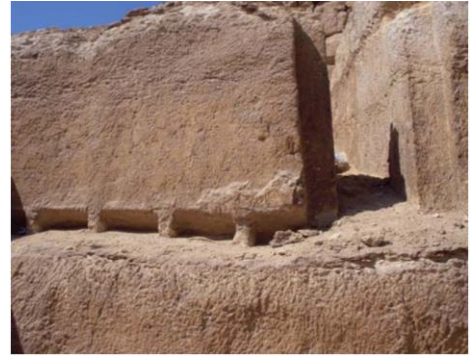
Kireçtaşı bloğun etrafında bronz keski ile açılmış kanallar ve manivela ya da kama sokmak için tabanda açılmış yuvalar - Eski Krallık, Giza, Mısır
