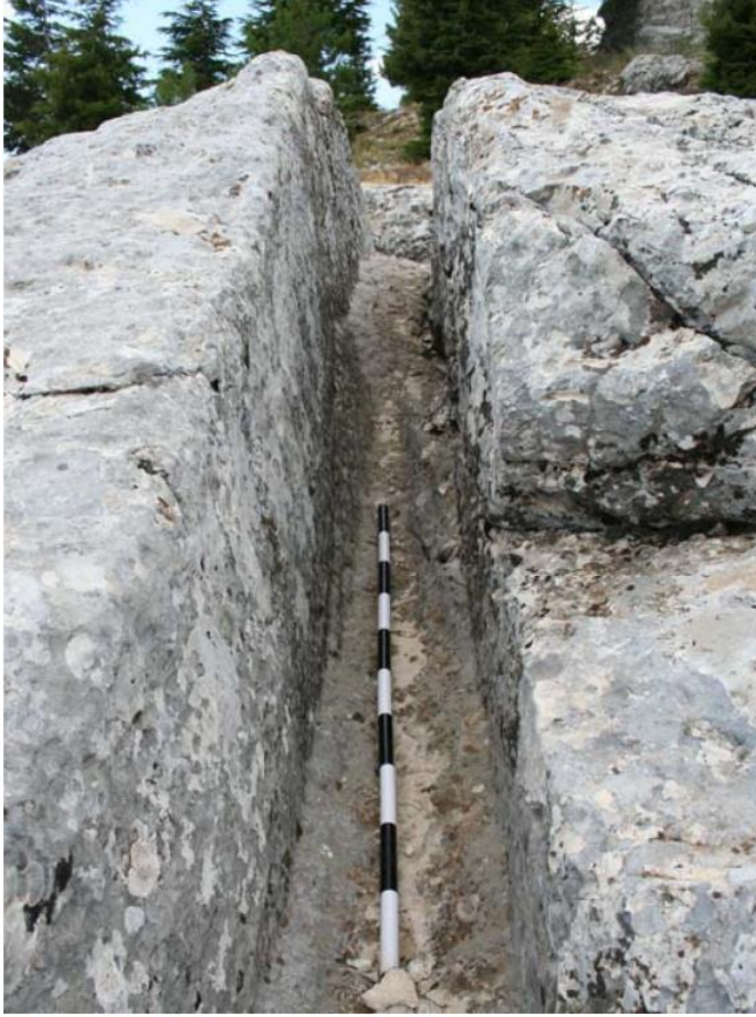
Kireçtaşı ocağında Romalıların uyguladığı kanal yöntemi – Sagalassos /Ağlasun / Burdur
